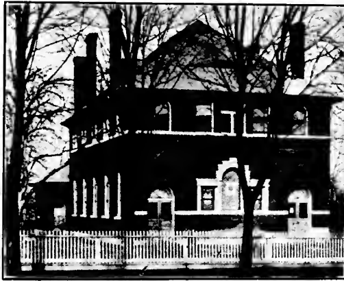
Kessler-Halle, Aula und Konservatorium.
