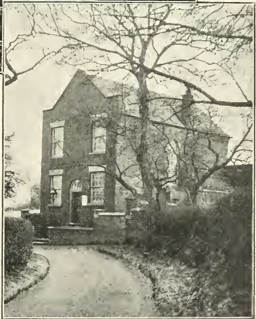
ENGLESEA BROOK CHAPEL. (Exterior.)
